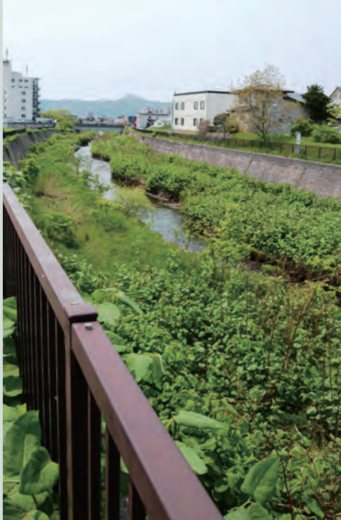
函館市中道付近の亀田川左岸から下流を望む
