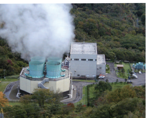
1982年11月に運転を開始した森発電所
