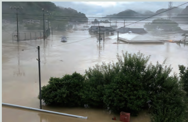
住宅は屋根まで浸水し、必死で2階に逃れながら水死した犠牲者がいた。
